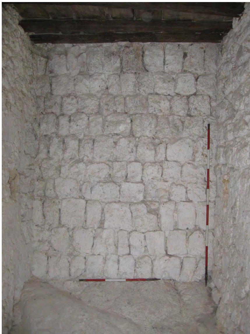
Fig. 12 – Tratto di muratura medievale individuata durante i lavori di restauro della chiesa di S. Maria della Rocca di Tolfa.
