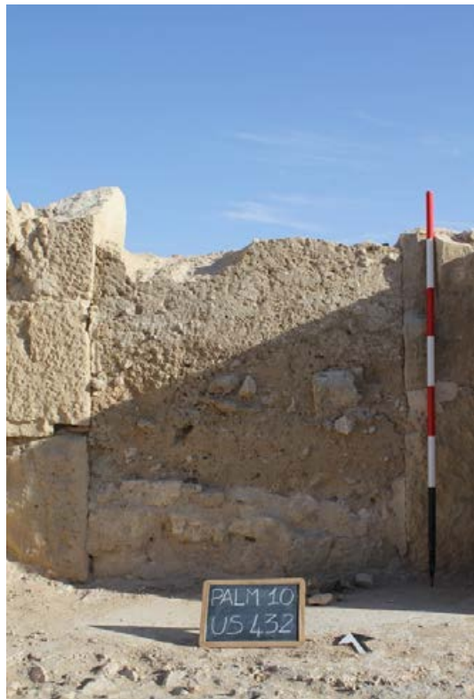
Fig. 8. Il tamponamento tra gli Ambienti B e G dell'Edificio con Peristilio (Archivio PAL.M.A.I.S.)
