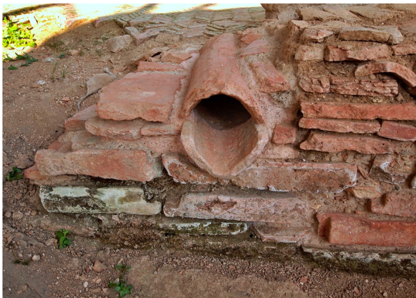
Fig. 13 Tubo che immette olio nella vasca di decantazione dell'Acquarella
