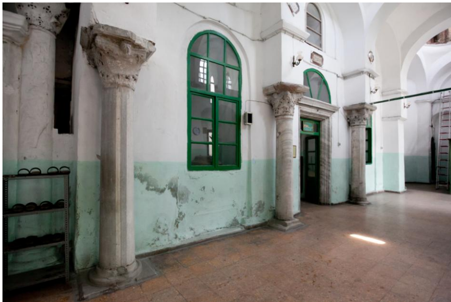
Fig. 31 – Istanbul, Vefa Kilise Camii, esonartece, interno, da nord ovest
