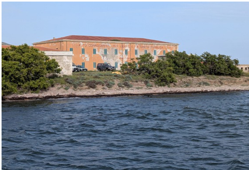
Stazione sanitaria marittima quarantenaria dell'Asinara, sede storica dell'Alto Commissariato per l'Igiene e la Sanità. L'edificio fu Stazione sanitaria marittima di II classe durante il periodo della quarantena agli inizi del '900
