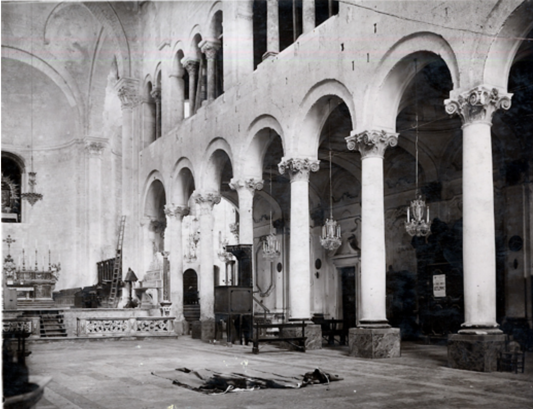
14 San Sabino, Bari. Interno durante i lavori di restauro diretti da Carlo Ceschi, 1934 (da Derosa 2009).
