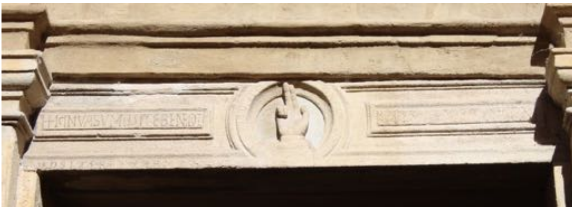
3 Piacenza, ex chiesa di San Matteo, architrave del portale ovest
