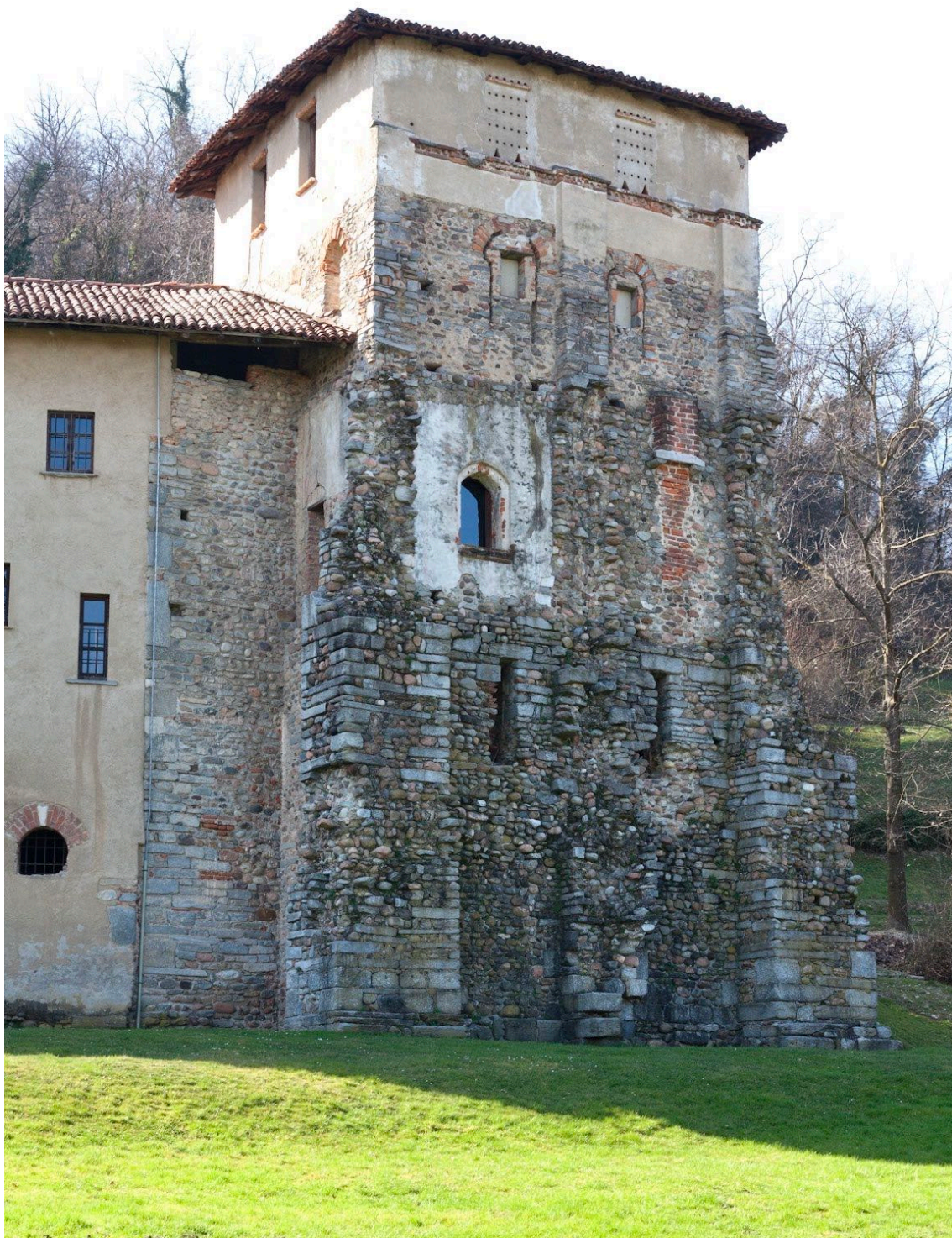
3 Torba, torre tardoantica, prospetto orientale (foto dell'Autore, 2017)
