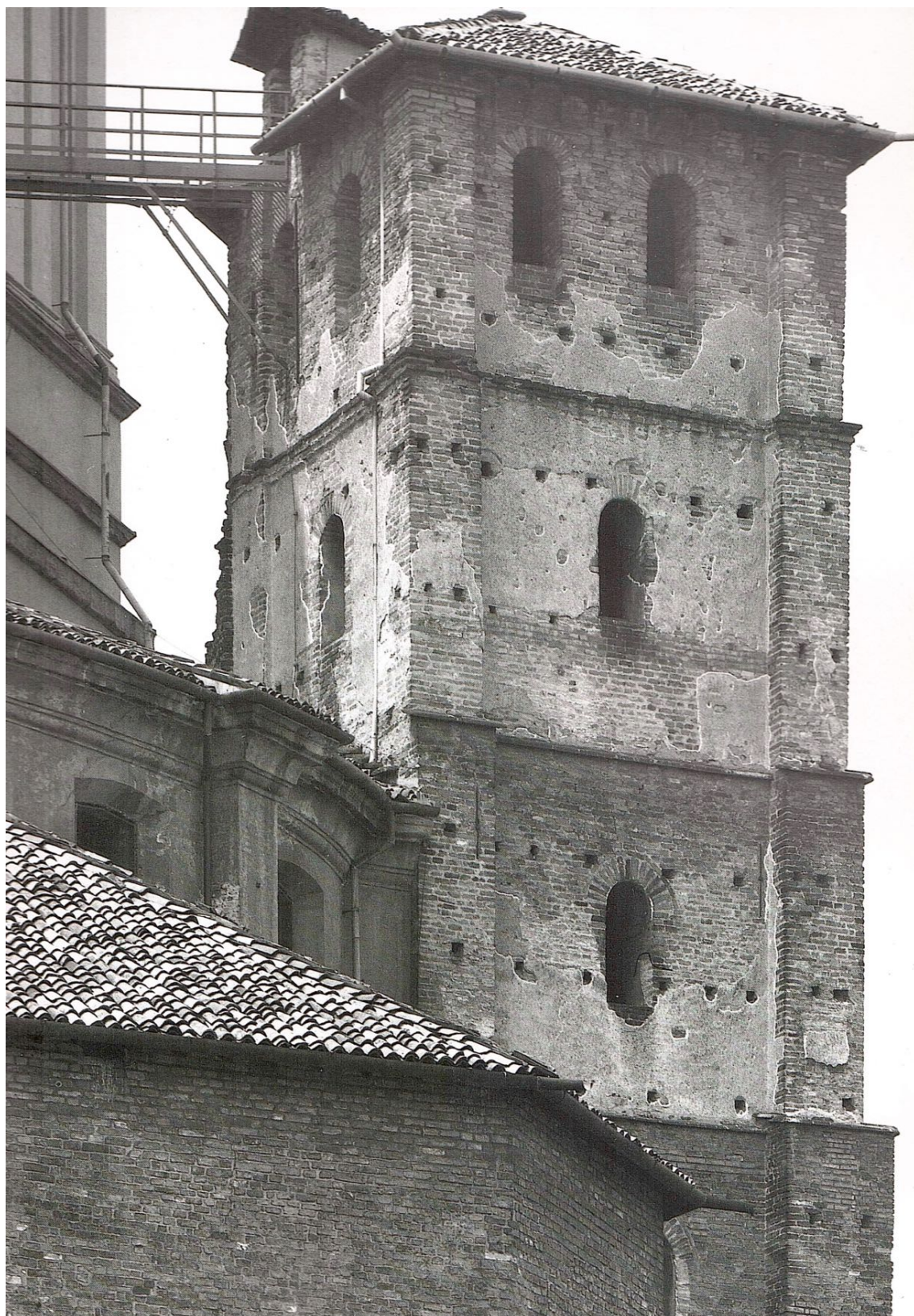
5 Milano, San Lorenzo Maggiore, torre nord-est (da Dell'Acqua 1985)
