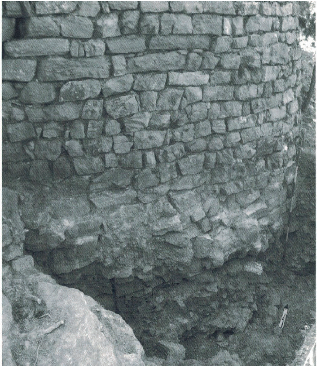
5 Il lato esterno del muro curvilineo con la fondazione
