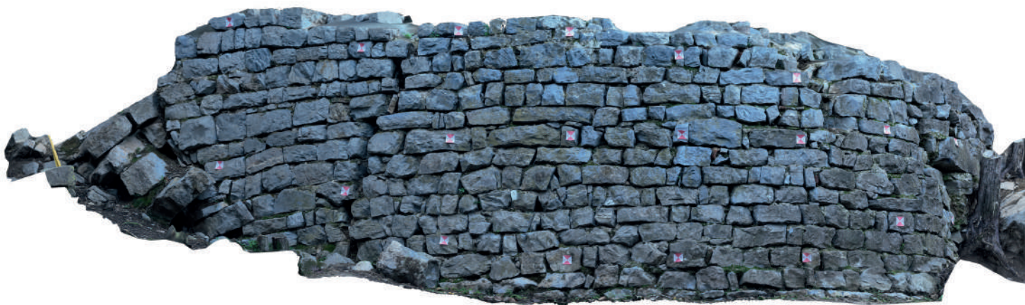
6 Fotopiano della muratura dell'edificio curvilineo
