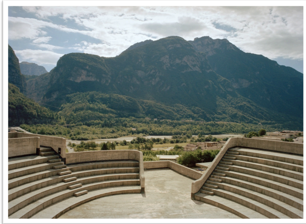
Figure 8. The external amphitheatre of the Chiesa di Longarone. 48
