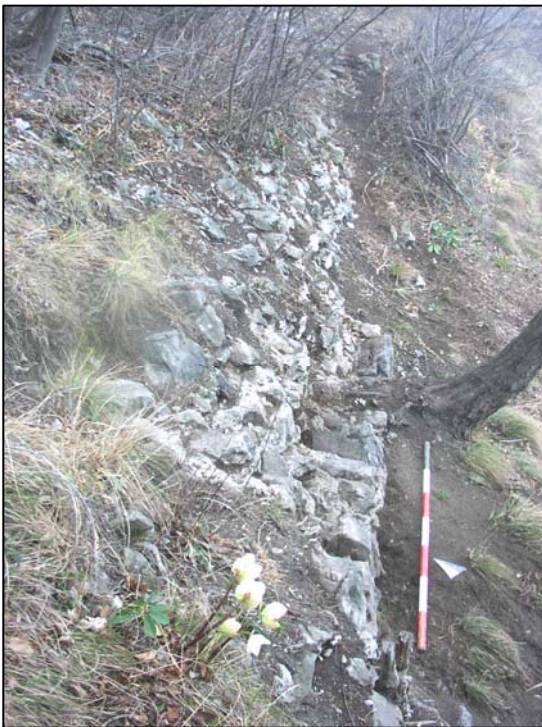
Fig. 7. Il muro di terrazzamento inferiore del corridoio di comunicazione.
