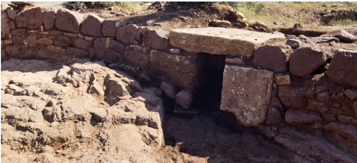
Fig. 4. Canale di raccolta delle acque meteoriche e tavola votiva riutilizzata (CHIESA 2016, fig. 4).
