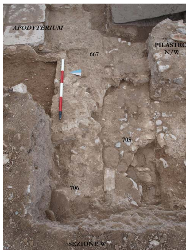
Fig. 15. Lato N dell'ambiente G: 705 muro rasato, 706 muro rasato, 667 malta di allettamento del lastricato dell' apodyterium .
