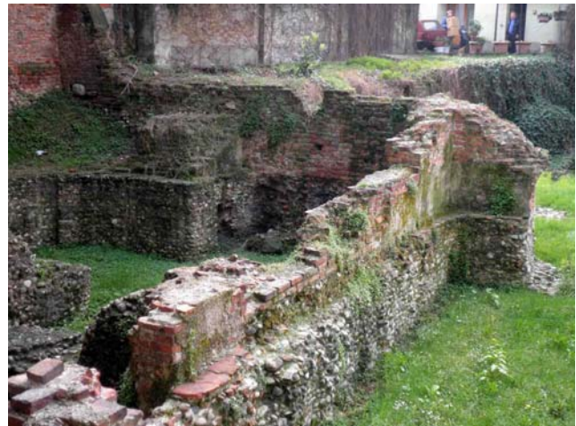
Fig. 5. Edificio di via Brisa, ambiente 2. (Immagine dell'autore).
