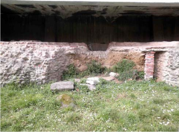
Fig. 8. Edificio di via Brisa, ambiente 5. (Immagine dell'autore).
