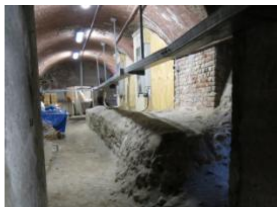
Fig. 4. Incongrua installazione di impianti su un tratto di muratura del complesso del Palazzo Imperiale.
