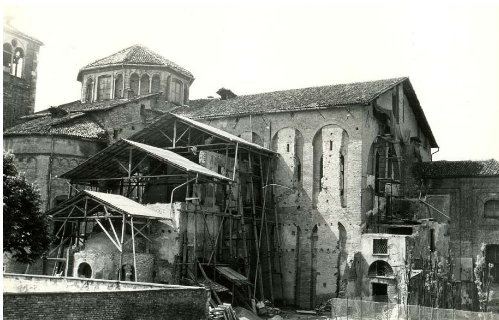
Fig. 2. Restauri della basilica di S. Simpliciano. Restauri della basilica di S. Simpliciano (archivio "E. Arslan" - Soprintendenza Archeologia della Lombardia).
