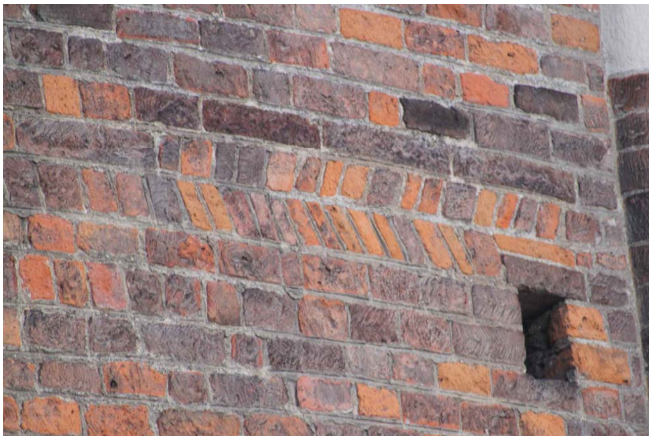
Fig. 9. Rigature dei laterizi e tecnica a spina-pesce sui paramenti esterni di San Nazaro Maggiore.
