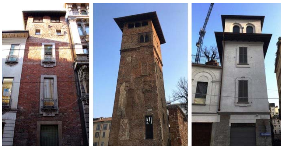
Fig. 11. Le case-torri attualmente visibili a Milano; da sinistra a destra la torre dei Meravigli, la torre dei Gorani e quella dei Morigi (foto dell'autore).
