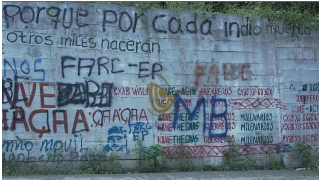
Figura 1. Muro di contenimento lungo la strada El Palo-Toribío. Municipio di Toribío, 15 settembre 2022. (Fotografia dell'autore)
