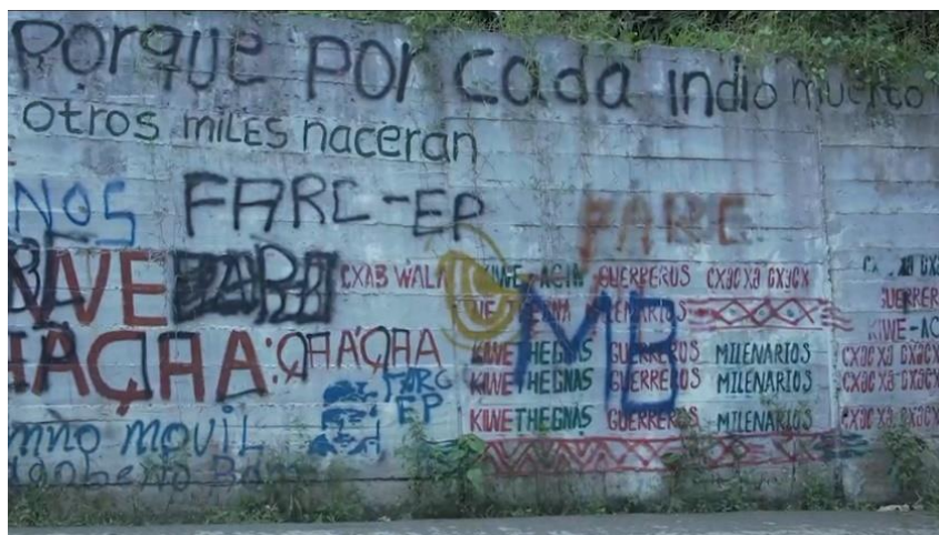
Figura 1. Muro di contenimento lungo la strada El Palo-Toribío. Municipio di Toribío, 15 settembre 2022. (Fotografia dell'autore)
